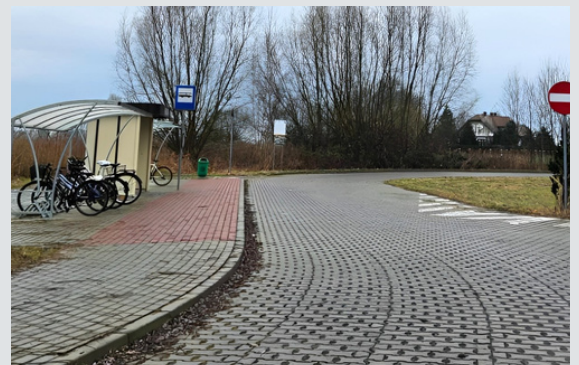
Przebudowa zatok autobusowych oraz montaż wiat przystankowych we Włostowie
