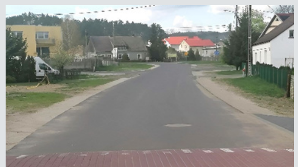
Przebudowa ul. Słonecznej w Jeninie
