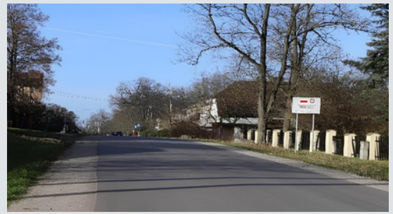
Przebudowa Drogi Powiatowej w Stanowicach
