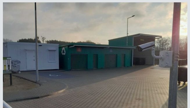
Budowa Punktu Selektywnego Zbierania Odpadów Komunalnych w Łupowie
