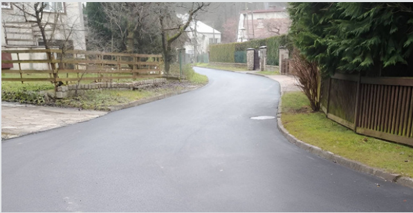
Przebudowa drogi Osiedle Przylesie w Jeninie
