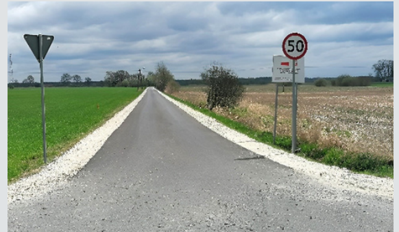
Budowa drogi Chwałowice - Roszkowice - Włostów
