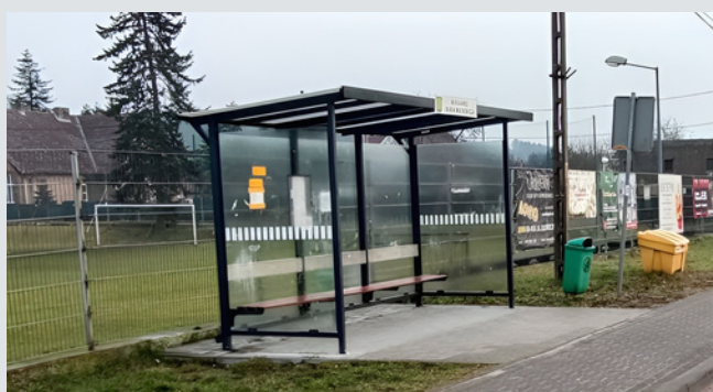
Wymiana wiat przystankowych na ul. Mickiewicza w Bogdańcu
