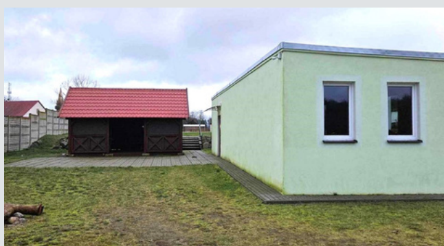
Budowa budynku socjalnego w Podjeninie
