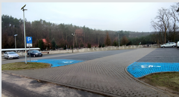
Budowa Parkingu przy ul. Akacjowej i Leśnej w Bogdańcu
