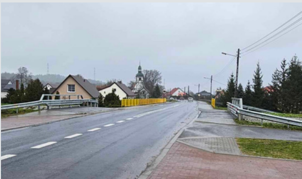
Przebudowa mostu na drodze wojewódzkiej nr 132 w Łupowie
