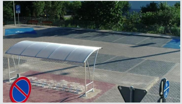
Budowa zatoki autobusowej i parkingu przy Szkole Podstawowej w Jeninie
