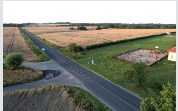
Przebudowa Drogi Powiatowej Racław - Baczyna
