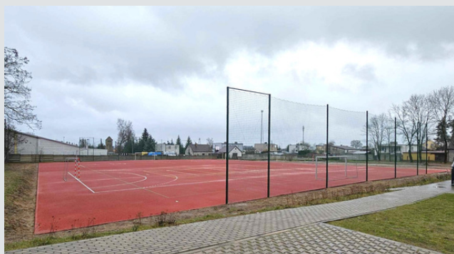
Budowa boiska wielofunkcyjnego przy Szkole Podstawowej w Jeninie
