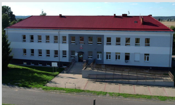
Termomodernizacja Szkoły Podstawowej w Lubczynie
