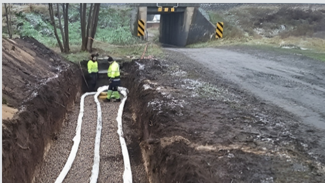
Wykonanie drenażu rozsączającego na ul. Topolowej w Łupowie
