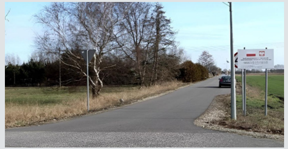
Przebudowa drogi w Kwiatkowicach
