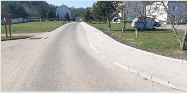
Budowa chodnika na ul. Leśników w Łupowie
