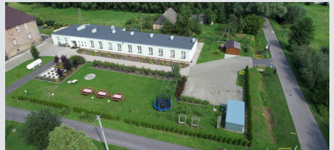
Budowa Środowiskowego Domu Samopomocy w Krzyszczynie
