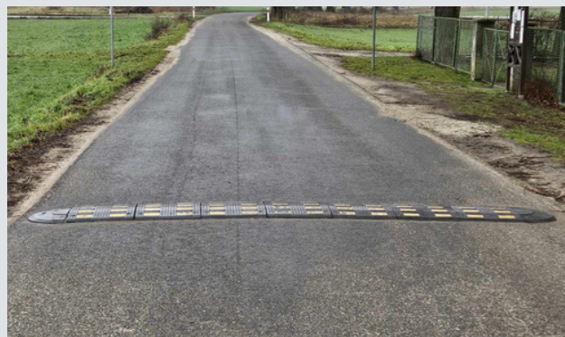
Montaż progów zwalniających przy Szkole Podstawowej w Lubczynie
