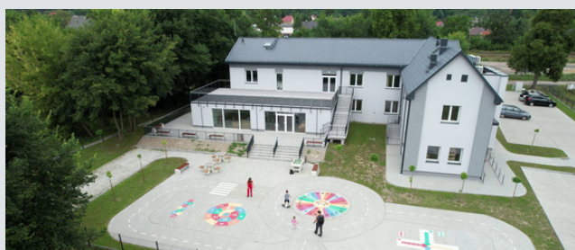
Remont Gminnej Biblioteki Publicznej w Bogdańcu
