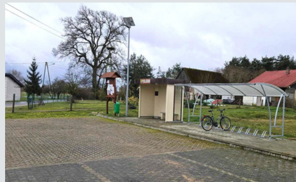
Budowa zatoki autobusowej oraz wiaty przystankowej w Podjeninie
