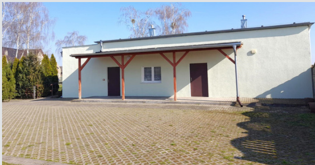
Remont sali wiejskiej w Jeżykach
