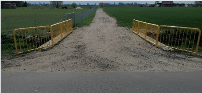
Przebudowa przepustu na kanale wieprzyckim
