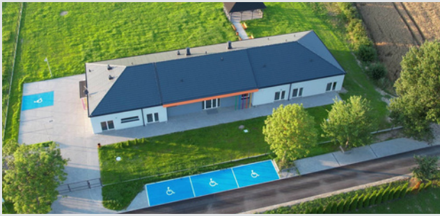
Budowa Centrum Opiekuńczo - Mieszkalnego oraz drogi dojazdowej w Raławiu
