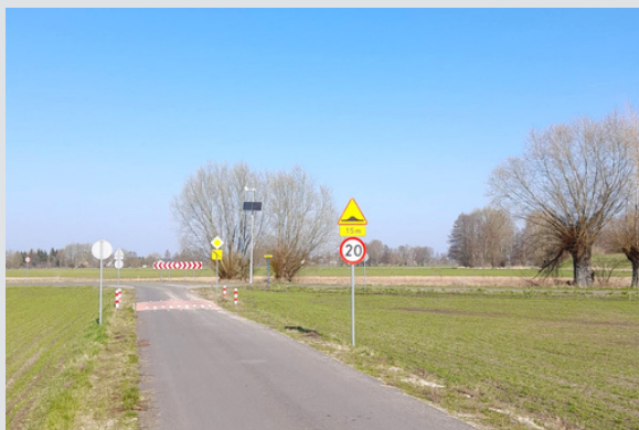
Budowa drogi Chwałowice - Roszkowice
