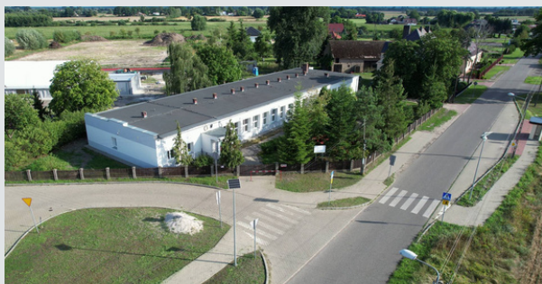
Remont kompleksowy Szkoły Podstawowej w Jenińcu, przebudowa zatok autobusowych oraz budowa parkingu
