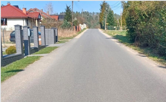
Budowa ul. Akacjowej w Jeninie
