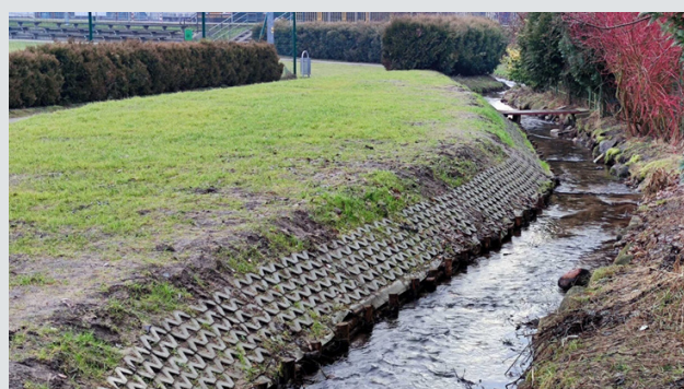
Konserwacja kanału Bogdanka
