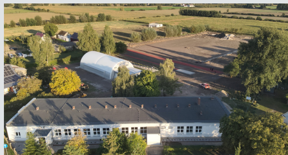
Budowa kompleksu sportowego przy Szkole Podstawowej w Jenińcu
