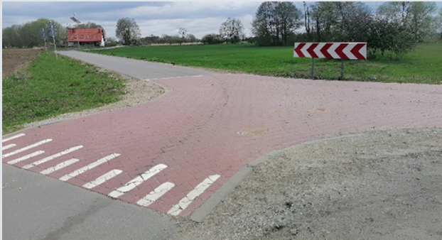
Przebudowa dróg gminnych w Lubczynie i Jasińcu
