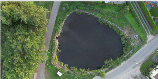
Prace melioracyjne na zbiornikach retencyjnych I i II w Raławiu
