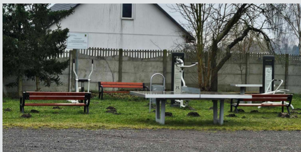
Montaż siłowni napowietrznej przy OSP w Lubczynie
