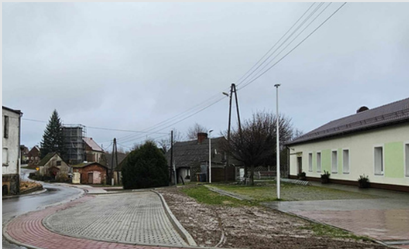
Budowa Chodników oraz parkingów w Stanowicach
