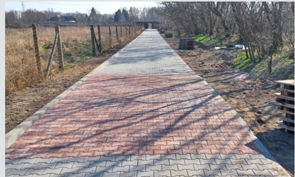
Budowa ul. Polnej w Łupowie
