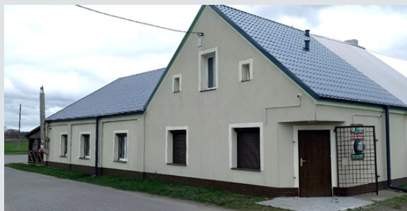
Remont kompleksowy sali wiejskiej we Włostowie
