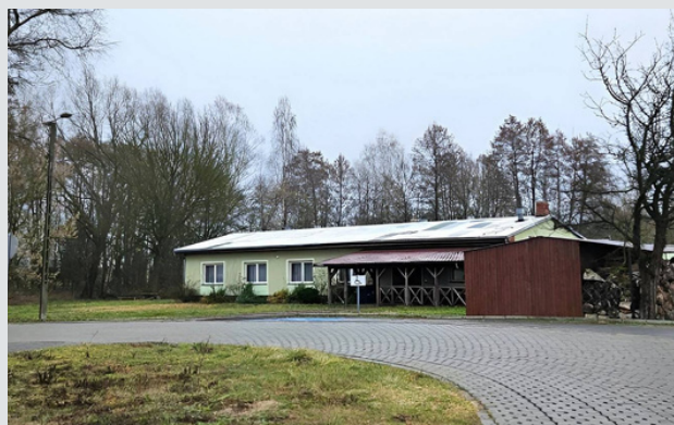
Budowa zatoki autobusowej w Chwałowicach
