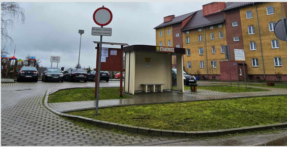
Przebudowa zatok autobusowych w Stanowicach
